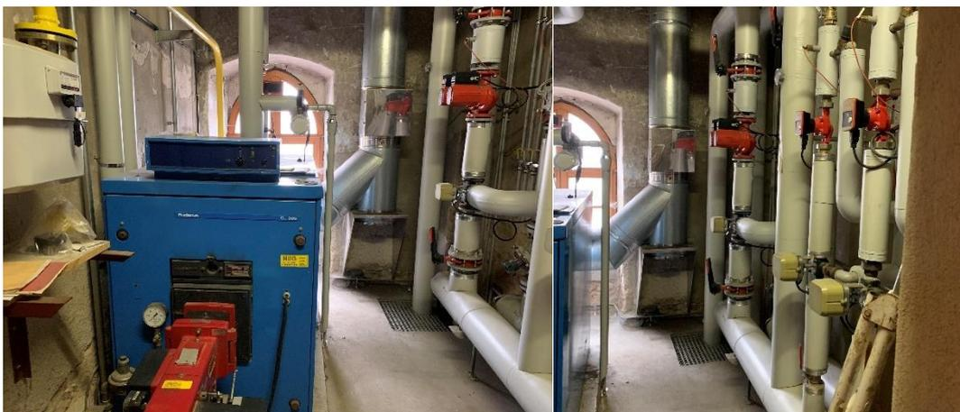
**Figure 3 : Chaudière gaz et distribution dans la chaufferie de la mairie**
