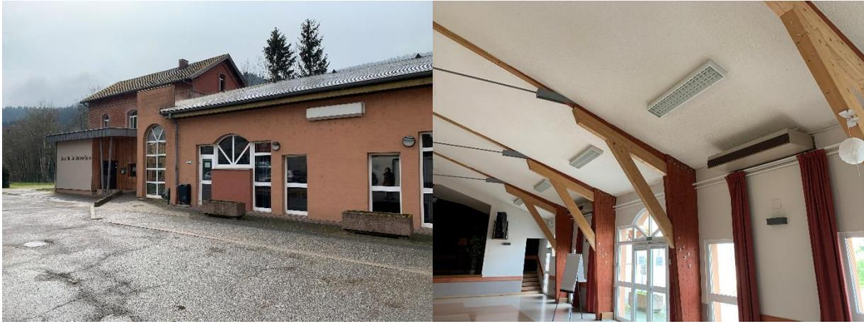
**Figure 10 : Salle polyvalente / aperçu des aérothermes dans la salle (droite)**
